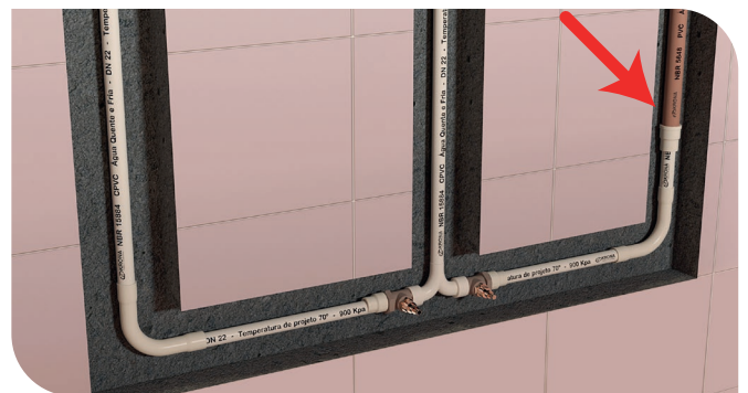
Transição soldável com a Luva de Transição CPVC x PVC.
